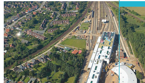
Gleisanlagen mit Wartungshalle Husum
